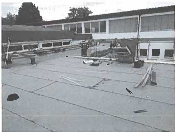
Das Flachdach am Anbau der Festhalle Diersheim wird saniert
